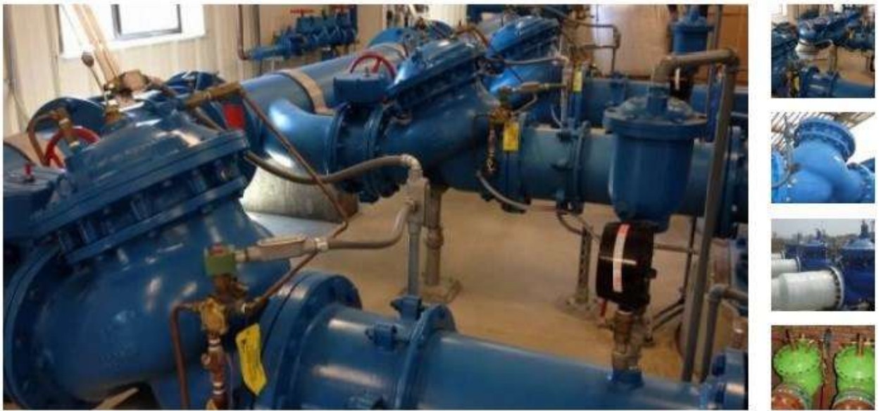
Рисунок 5.6 – Общий вид клапанов для гашения гидроударов Vermad (Израиль)
