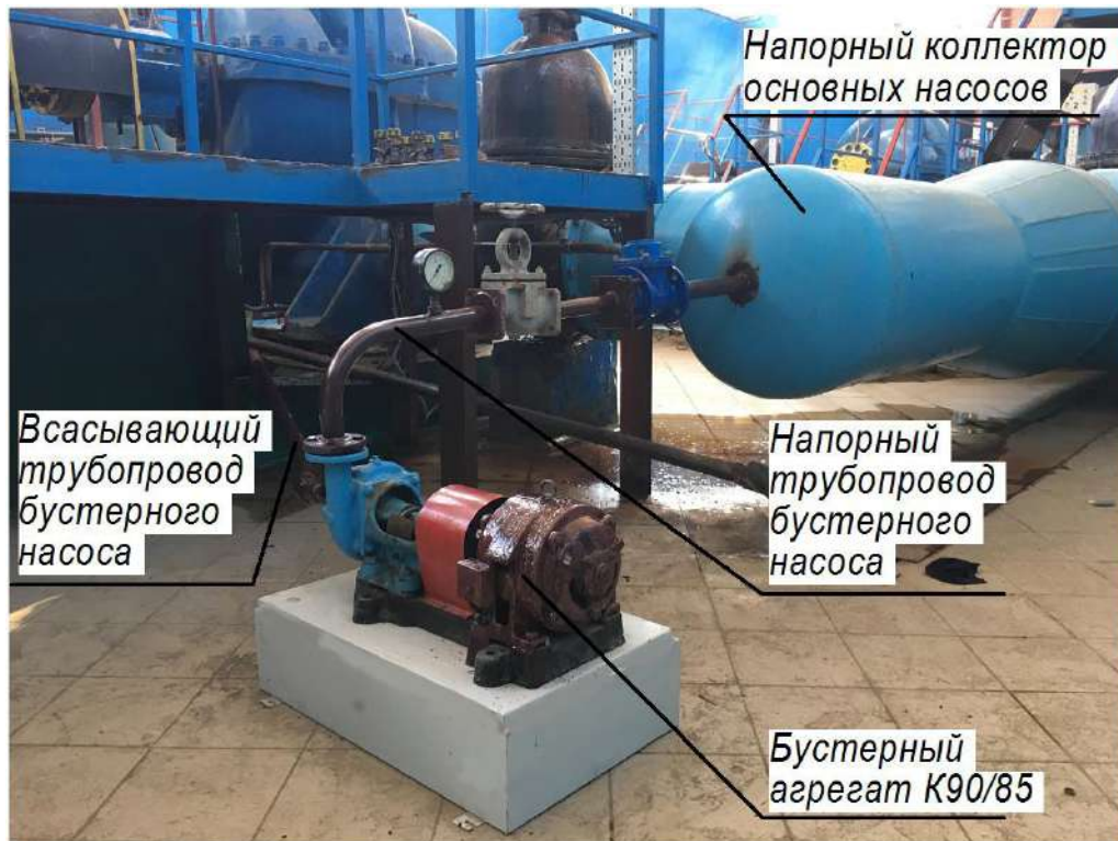
Рисунок 2.8 – Расположение бустерного агрегата на исследуемой насосной станции «Междуречье»
