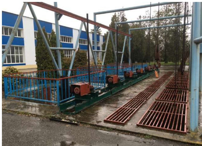
Рисунок 2.2 – Шандорное перекрытие насосной станции «Междуречье»
