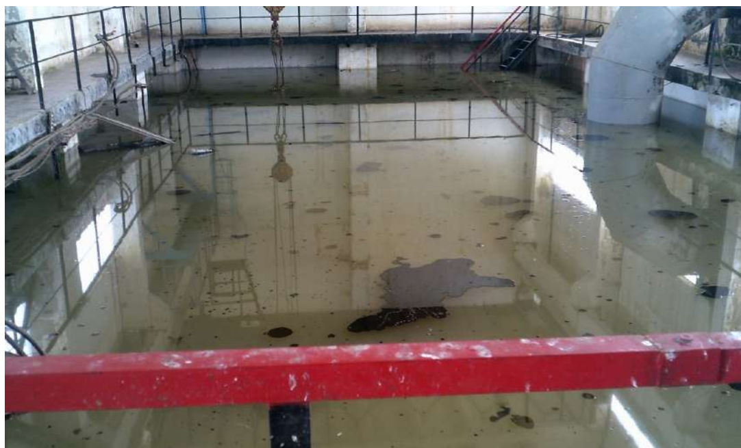
Рисунок 1.4 – Арзгирская головная насосная станция Ставропольского края после аварии в результате гидравлического удара в напорном трубопроводе (2 июня 2015 год)
