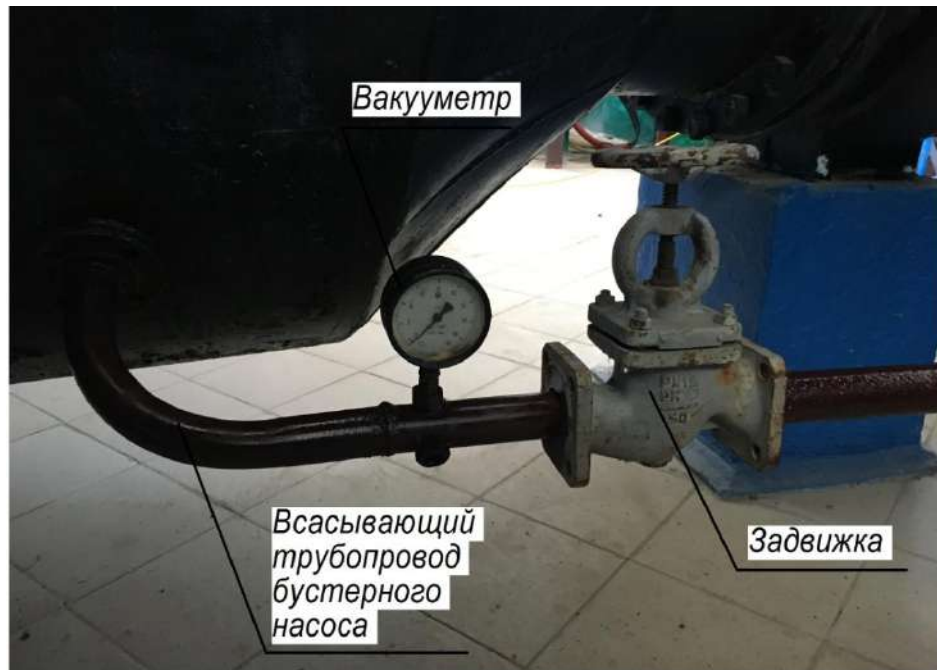
Рисунок 3.7 – Опытное определение величины вакуума на всасывающем трубопроводе бустерного насоса
