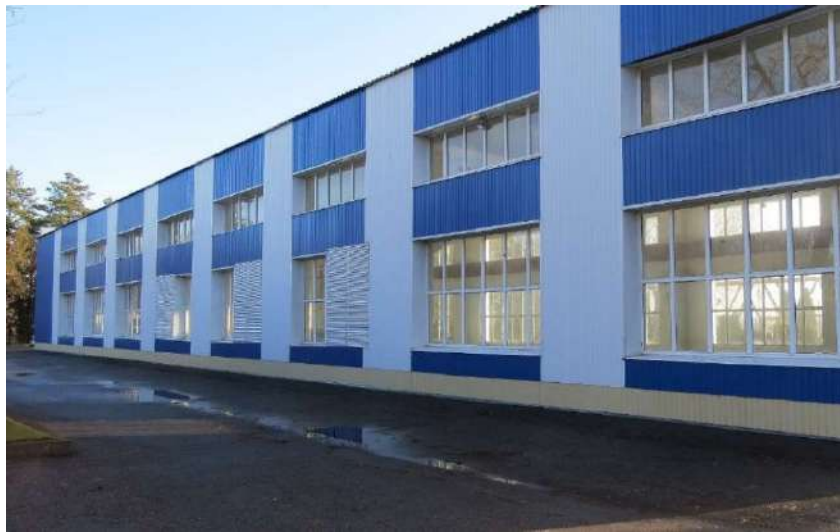
Рисунок 2.1 – Общий вид насосной станции «Междуречье»
