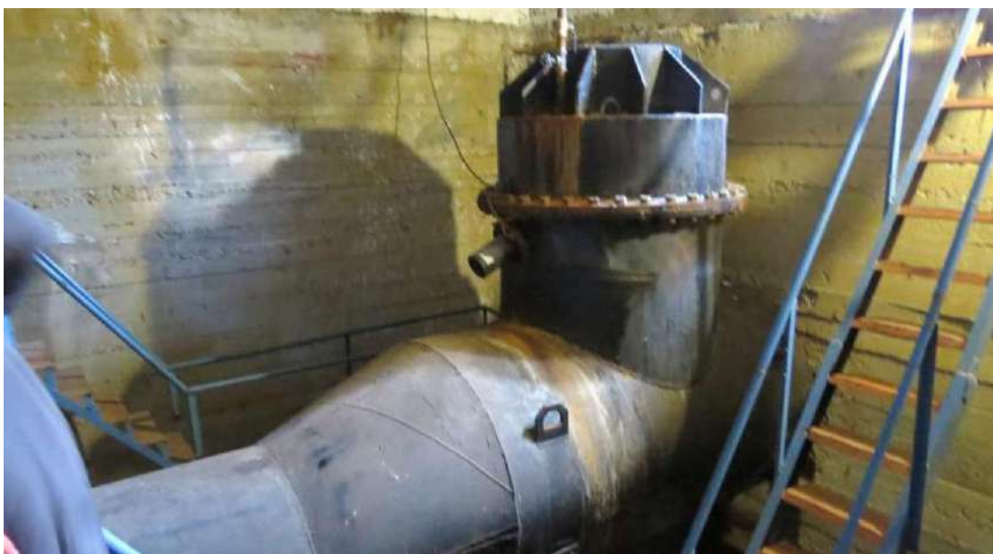
Рисунок 1.3 – Общий вид обратного клапана, используемого на напорных трубопроводах мелиоративных насосных станций
