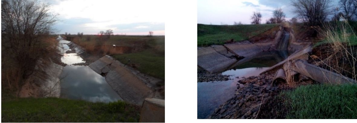
Рисунок 4.5 – Размывы в русле на быстротоке канала ПР-1
