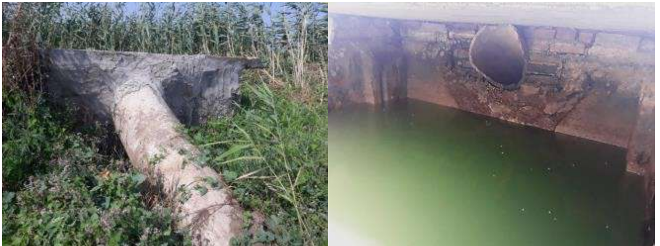
Рисунок 29 – Отводящая (переливная) труба дренажного колодца (ООО «Золотовское», Семикаракорский район Ростовской области) [67,103]
